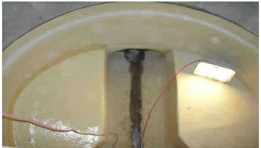
Abb. 9 und 10: Schachtbilder, Quelle:Firma Frisch & Faust Tiefbau GmbH
