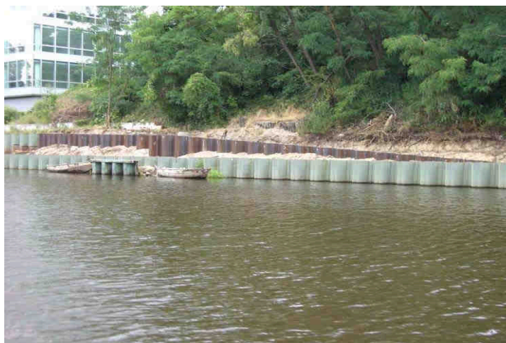
Abb. 5 Einleitungsbauwerk für Mischwasser aus Regenüberläufen, Quelle: privat
