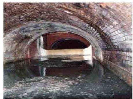
Abb. 4: Regenüberlaufwehr, Quelle: BWB
