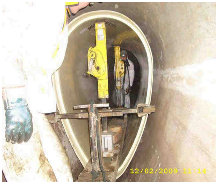
Abb. 19: Das Bild zeigt ein so genanntes Rohr-Relining zur Sanierung eines brüchigen Abwasserkanals mit Kurzrohren als Alternative zum Schlauchlining,
