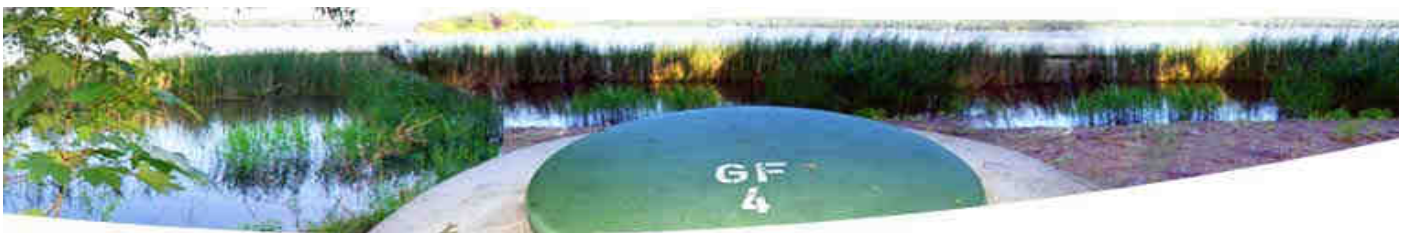
Abb. 31: Brunnen für Uferfiltrat, Quelle: BWB
