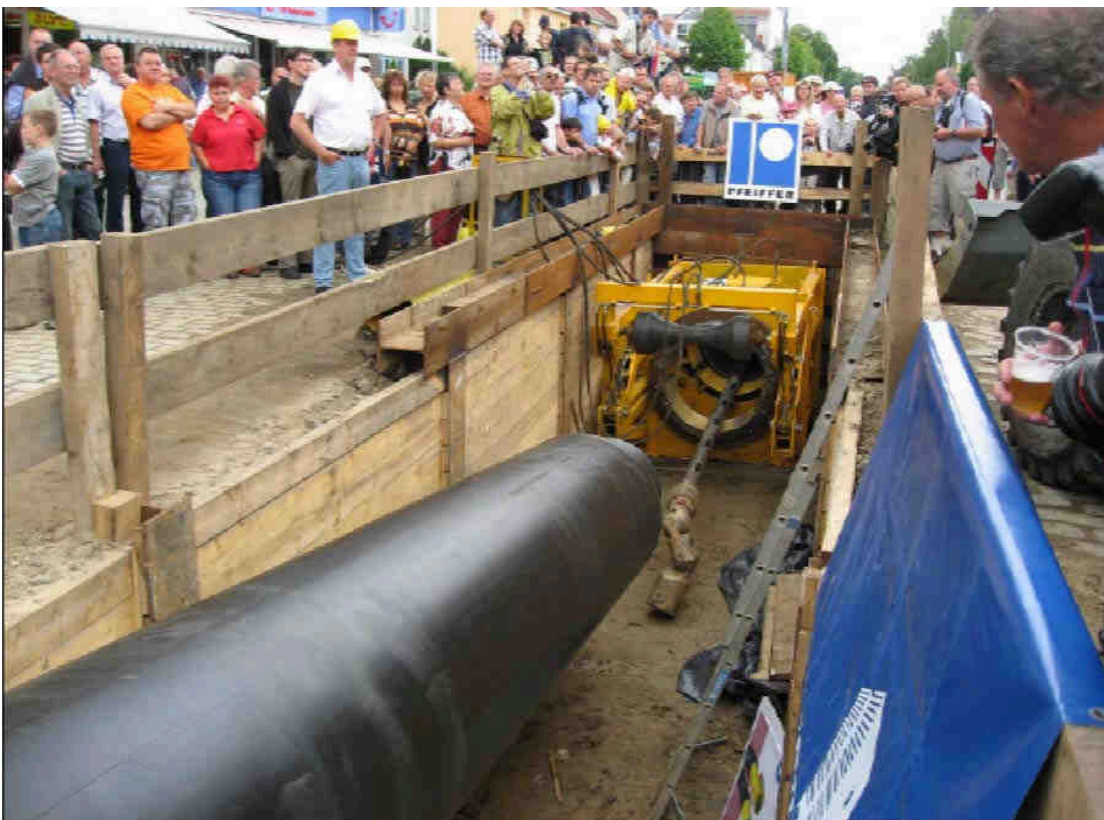
Abb. 33: Lining direkt vor dem Einzug
